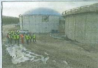
En 2018 sur le chantier du méthaniseur des Deux vallées à Scherwiller. Photo archives DNA/Franck DELHOMME
